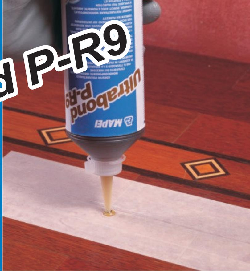
**Однокомпонентный гидрорасширяющийся полиуретановый клей для фиксации и ремонта паркета, который плохо закреплен на основании, наносится методом инъекций.**
