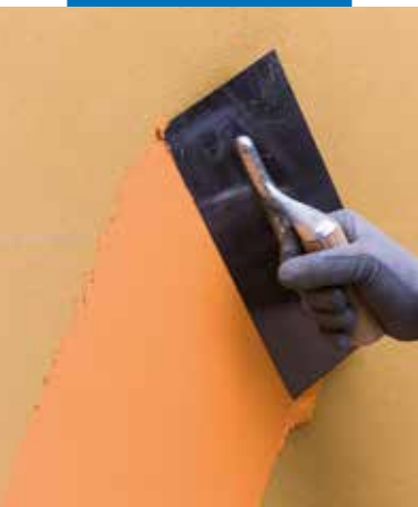
Нанесение Mapetherm Flex RP
