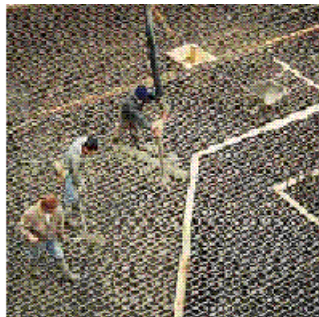
Подробности отливки станины фундамента с супержидким бетоном, смешиваемым с MAPEFLUID PZ500
