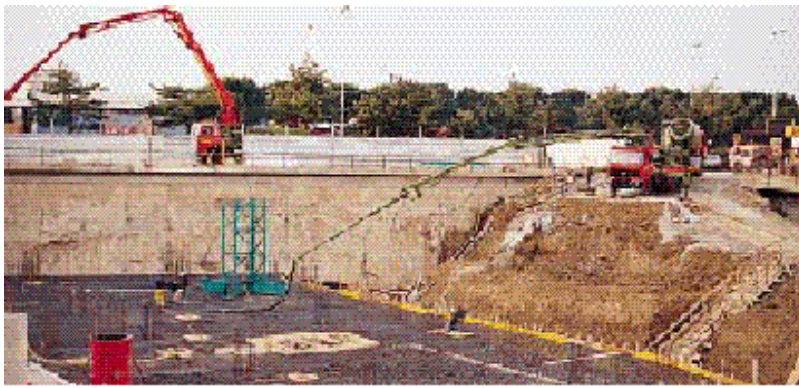
Отливка водонепроницаемой станины фундамента бетоном, подготовленным с использованием MAPEFLUID PZ500
