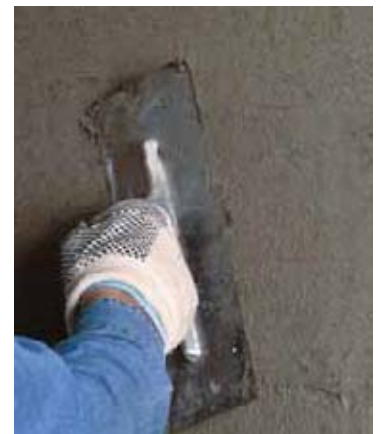
Нанесение финишного слоя
