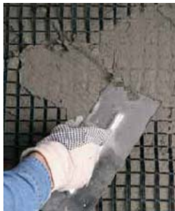
Фиксирование Mapegrid G220
