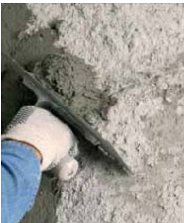
Нанесение 1 слоя Planitop HDM
