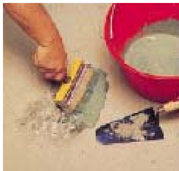
Нанесение адгезионного раствора
