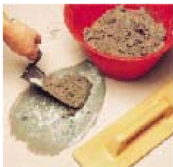
Нанесение выравнивающего раствора
