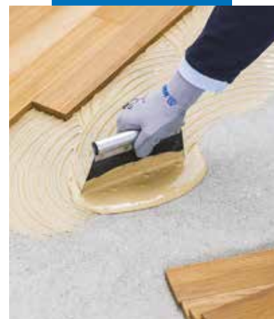
Нанесение клеевого раствора
