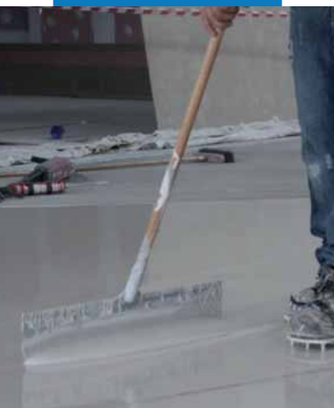
Нанесение самовыравнивающегося состава
