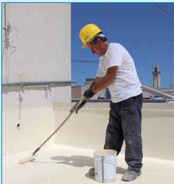
Нанесение Mapecfloor Finish 55
