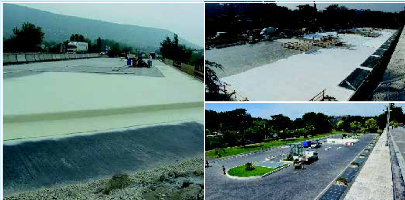
Примеры эксплуатируемых кровель с гидроизоляцией Purtop System Deck
