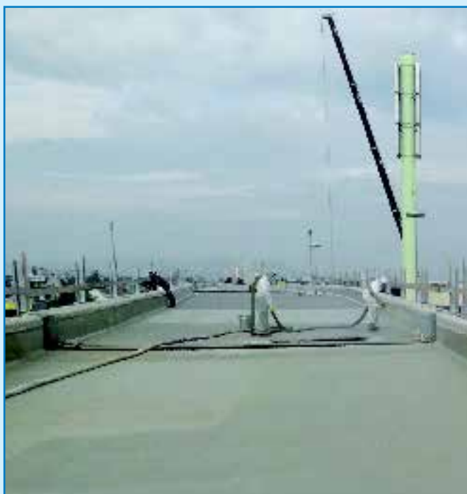
Полотно эстакады с гидроизоляцией Purtop 400 M
