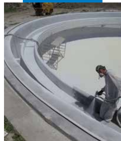
Нанесение Purtop 1000 на поверхность гидротехнических резервуаров
