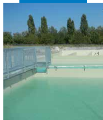
Гидротехнический резервуар с гидроизоляцией Purtop 1000
