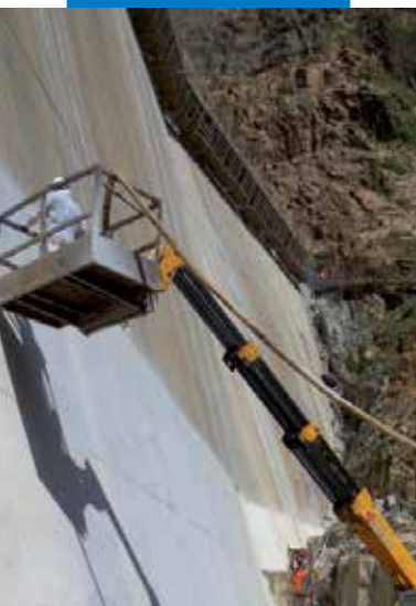
Гидроизоляция дамбы
