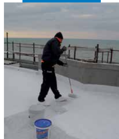
Нанесение валиком Triblock P на бетонную поверхность
