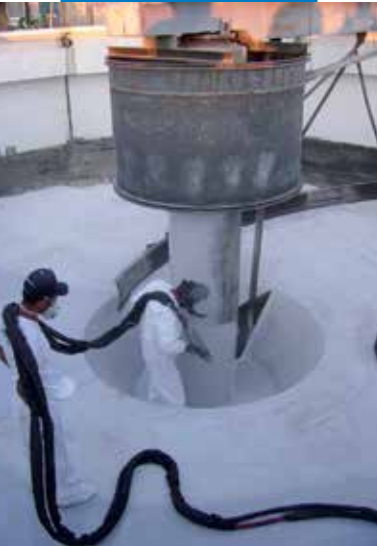
Особенности нанесения гидроизоляции Purtop 1000 на различных основаниях (цементных и металлических)
