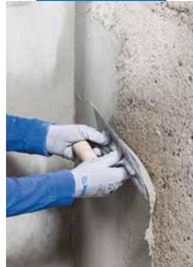
Нанесение Planitop Smooth&Repair R4 при помощи шпателя
