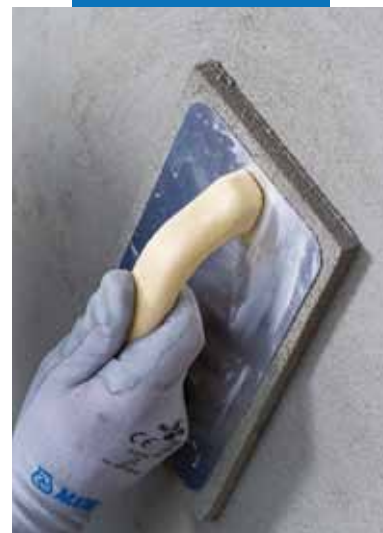
Сглаживание поверхности Planitop Smooth&Repair R4
