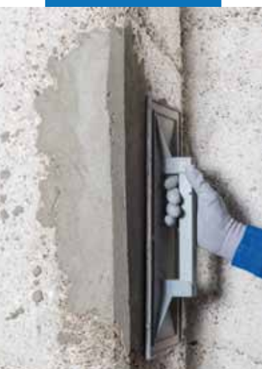
Уплотнение поверхности Planitop Smooth&Repair R4 для обустройства гладкой финишной поверхности
