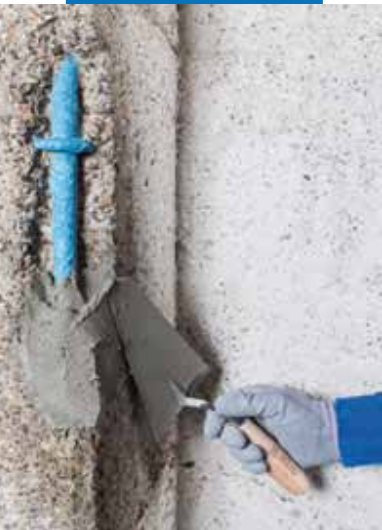
Нанесение Planitop Smooth&Repair R4 при помощи шпателя
