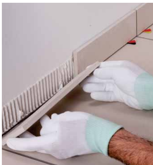
Уложите плинтус по периметру, без прямого контакта с полом
