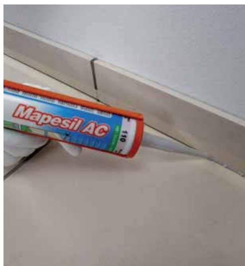
Заполните пространство между плинтусом и полом подходящим эластичным герметиком Mapei.
