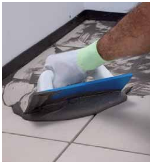
Заполните швы на поверхности
