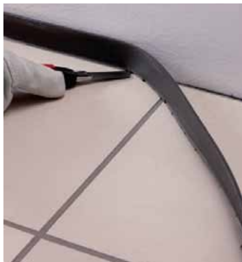
Когда наполнитель затвердеет, обрежьте лишние части Mapesonic Strip по периметру
