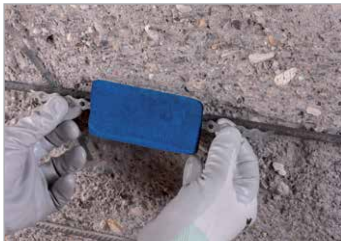
Укладка Mapeshield I на ремонтируемую конструкцию
