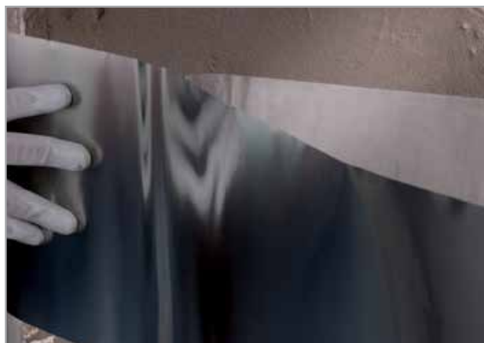
Укладка Mapeshield E 25 на наружную поверхность конструкции
