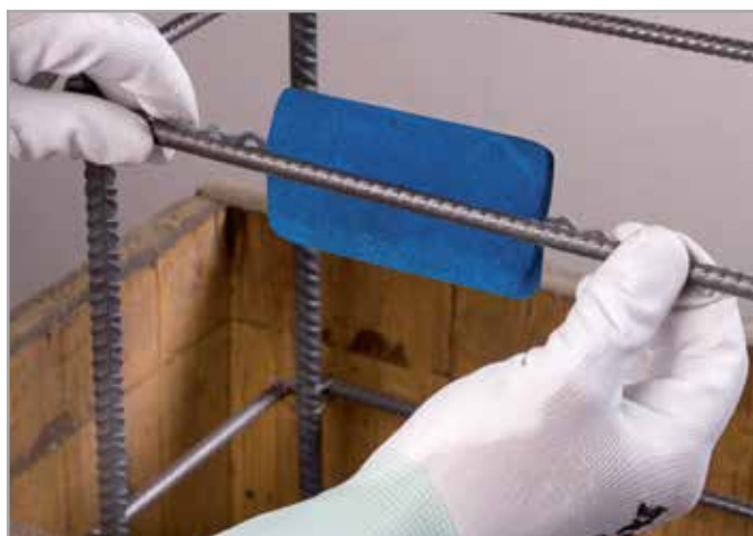
Укладка Mapeshield I на новую конструкцию
