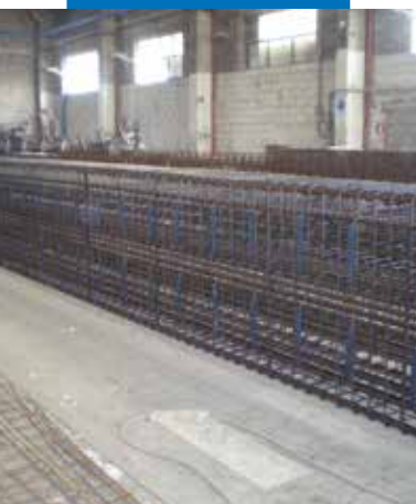
Приваренный Mapeshield I к армированию новой балки конструкции портового причала
