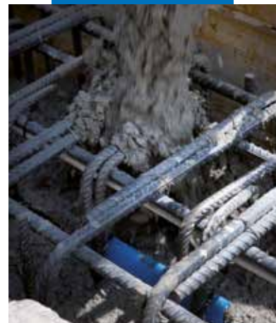
Выливание бетона для конструкций, защищенных при помощи Mapeshield I
