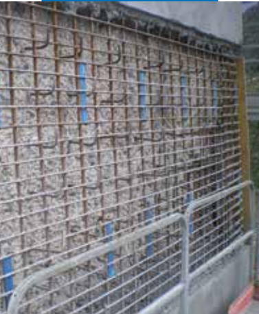
Крепление Mapeshield I к ремонтируемой свае виадука
