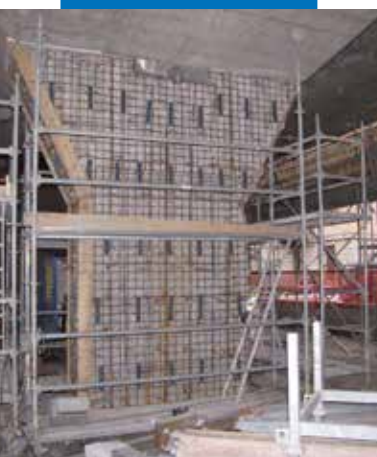
Крепление Mapeshield I к армированию сваи эстакады
