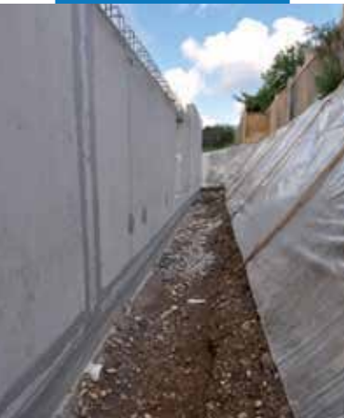
Герметизация структурных швов на наружных стенах
