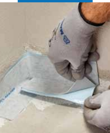
Нанесение Mapeband SA в углах
