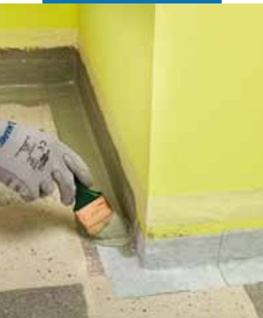
Нанесение Mapeband SA на стяжку
