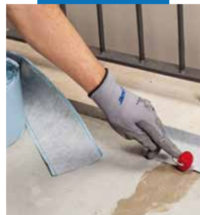
Нанесение Mapeband SA вокруг выступов
