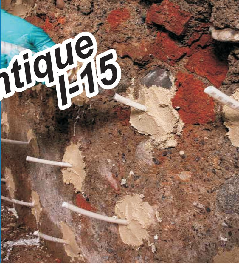
Солестойкий состав с мелкофракционным заполнителем и гидравлическим вяжущим на основе извести и Эко-Пуццоланы для приготовления высокотекучих инъекционных растворов, укрепляющих кладку.
