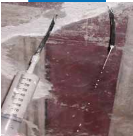
Инъекции Mape-Antique F21 в стену с фресками
