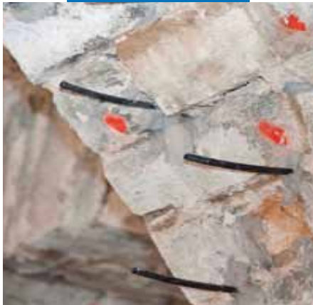
Пример крепления инъекционных трубочек
