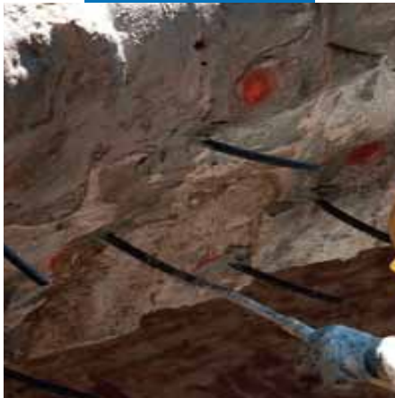
Инъекции Mape-Antique F21 в каменную кладку
