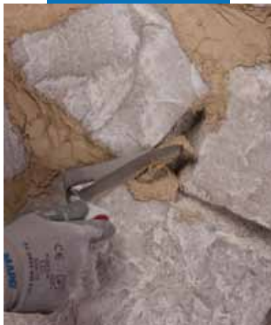
Заполнение швов каменной кладки
