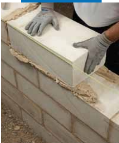
Укладка блоков из лещинского камня
