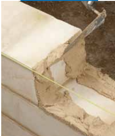
Нанесение Mape-Antique Allettamento
