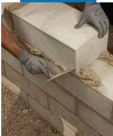
Удаление излишков раствора
