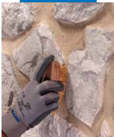
Финишная отделка поверхности с помощью шлифоваль- ной щетки
