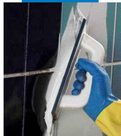
Нанесение Керароху СQ на стену специальным шпателем MAPEI
