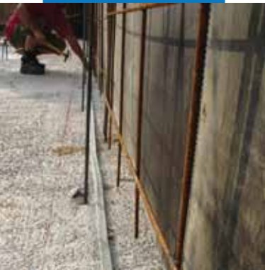
Укладка Idrostop B25
