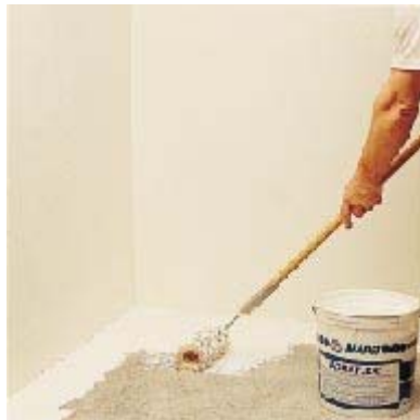
Нанесение AQUAFLEX валиком
