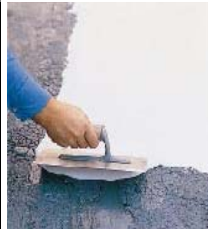
... нанесением AQUAFLEX (СПЕЦИАЛЬНЫЙ ДЛЯ АСБЕСТА)
