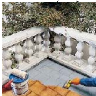
Нанесение PRIMER for AQUAFLEX
