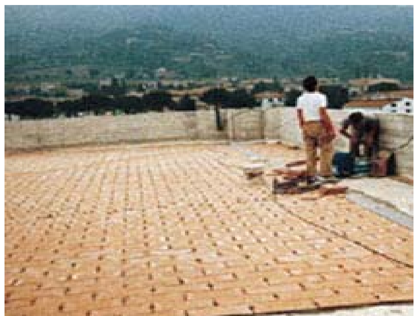
Укладка керамической плитки на гидроизоляционную мембрану AQUAFLEX
