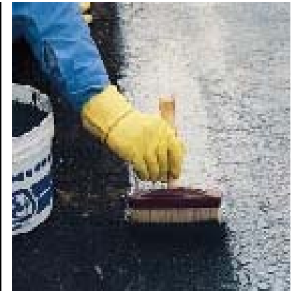
Нанесение PRIMER for AQUAFLEX на существующую асфальтовую мембрану перед...
