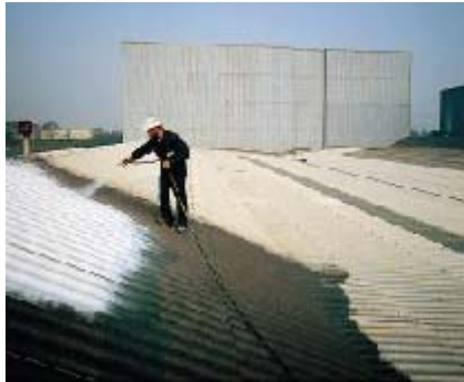
Нанесение AQUAFLEX (СПЕЦИАЛЬНЫЙ ДЛЯ АСБЕСТА) на гофрированный асбестоцемент (после предварительной обработки PRIMER for AQUAFLEX )
