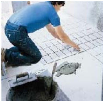
Гидроизоляция патио с помощью AQUAFLEX (СПЕЦИАЛЬНЫЙ ДЛЯ АСБЕСТА) и последующей облицовкой плиткой
