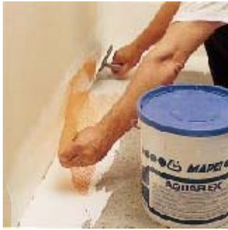
Армирование AQUAFLEX- гидроизоляционной мембраны синтетической тканью на углах
