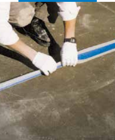
Пример гидроизоляции компенсационных швов на террасе
