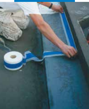
Пример использования Mapeband для гидроизоляции углов на стыке стена/пол в ванной
