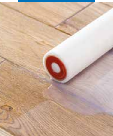
Нанесение двухкомпонентного вододисперсионного финишного покрытия Ultracoat
