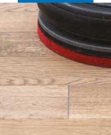
Шлифовка поверхности перед нанесением финишного покрытия
