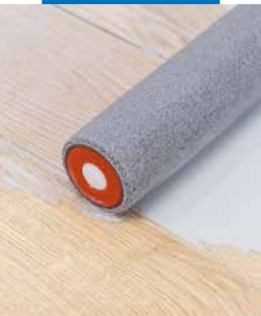
Нанесение материала при помощи валика
