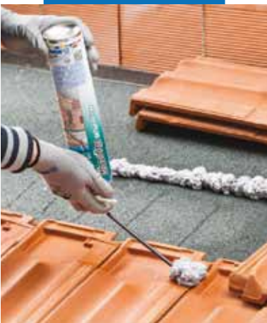
Точечное приклеивание кровельной черепицы
