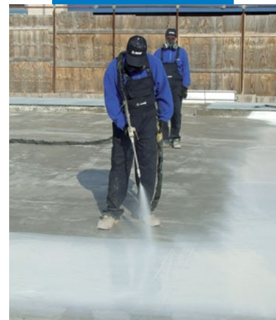
Нанесение Purtop 600 на плоскую кровлю с помощью распылителя
