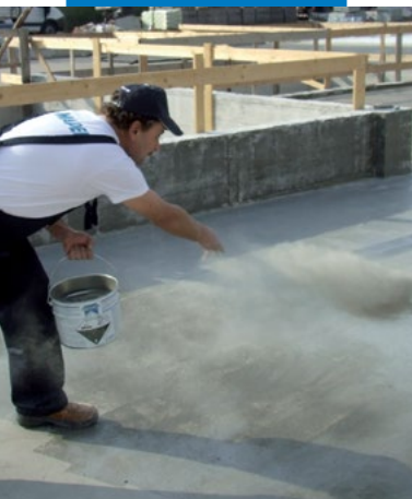
Посыпка песка Quarzo 0.5 на свежий Primer SN
