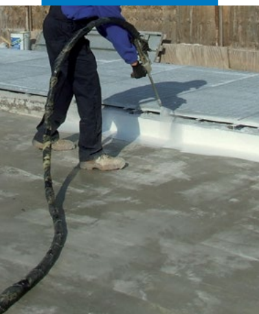
Нанесение Purtop 600 на углы примыкания с помощью распылителя
