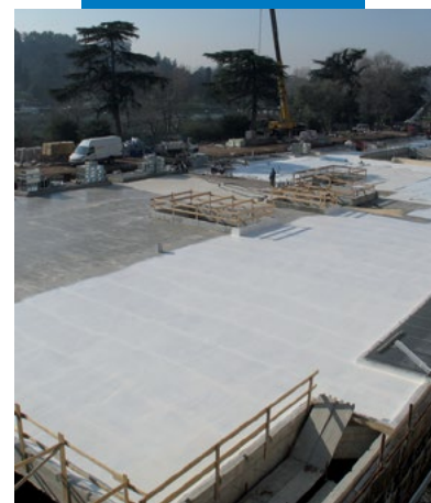
Обустройство гидроизоляции подземного паркинга с Purtop 600
