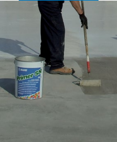
Нанесение Primer SN на бетонные плиты с помощью валика
