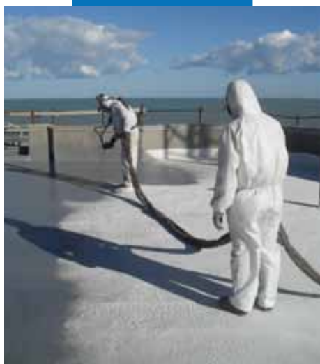
Нанесение Purtop 400 M на грунтровку Triblock P
