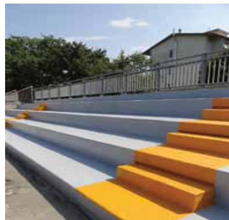
Зрительские трибуны с гидроизоляцией Purtop 400 M и финишным покрытием Mapefloor Finish 55
