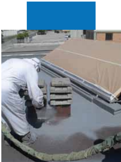
Нанесение Purtop 400 M на битумную мембрану
