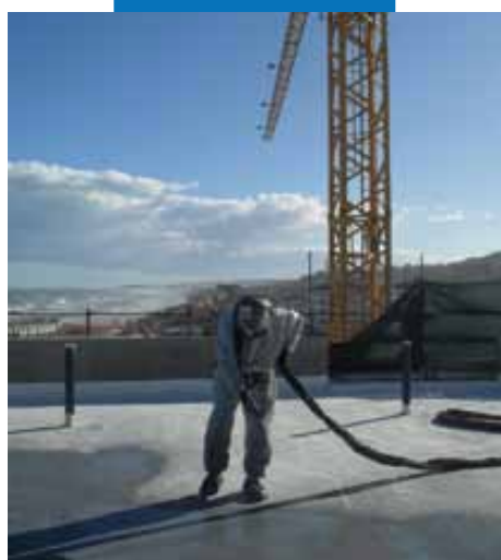
Нанесение Purtop 400 M на грунтровку Triblock P
