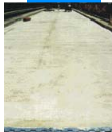
Вид восстановленного мостового настила
