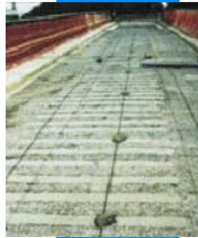
Пластины Carboplate, покрытые составом Maregrout BM
