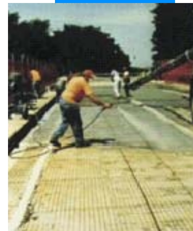
Наложение эпоксидной грунтовки
