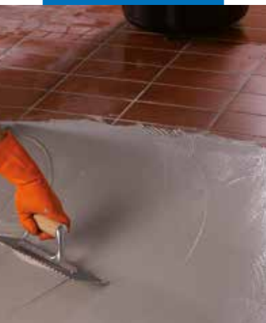
Нанесение второго слоя Monolastic по Mapenet 150
