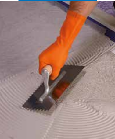
Нанесение первого слоя Monolastic с применением Mapetex Sel на новых стяжках
