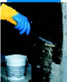
Нанесение второго слоя грунта Mapewrap Primer 1
