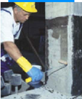
Нанесение первого слоя грунта Mapewrap Primer 1
