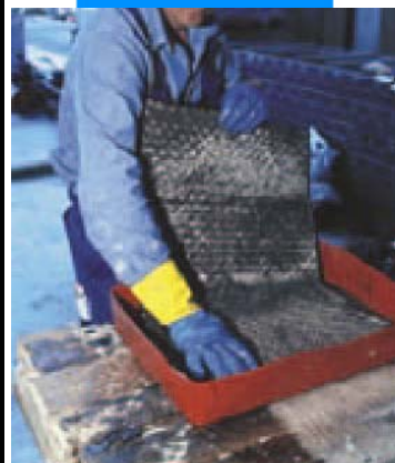
Ручная пропитка покрытия Марепрар C
