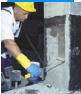
Нанесение Mapewrap Primer 1
