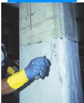
Нанесение шпаклевки Mapewrap 11 или Mapewrap 12
