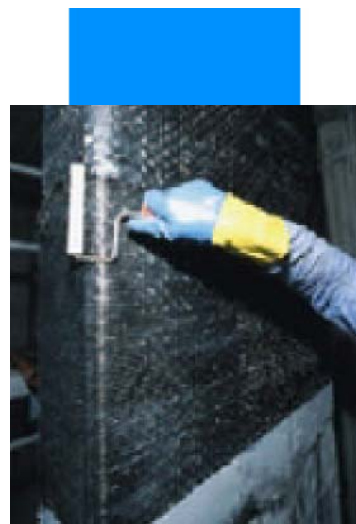
Нанесение второго слоя Mapewrap 31
