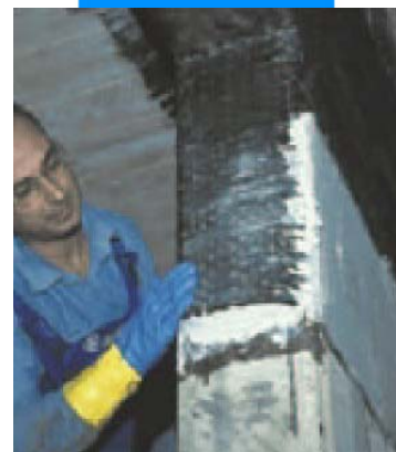
Обвязка колонн и балок
