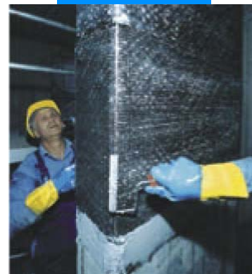
Укладка покрытия
