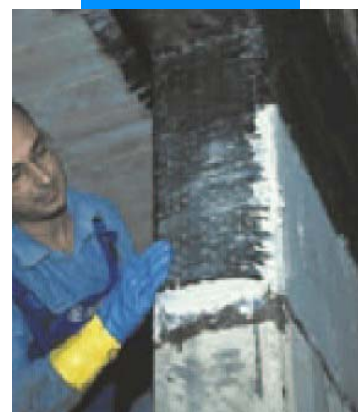
Обвязка колонн и балок
