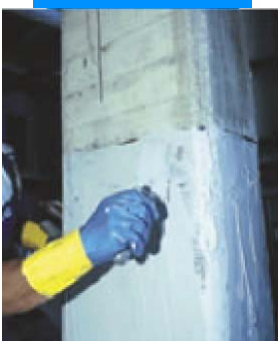
Нанесение шпаклевки Mapewrap 11 или Mapewrap 12
