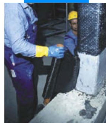
Укладка покрытия
