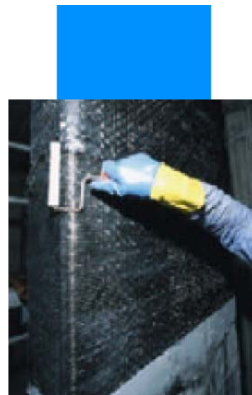
Нанесение второго слоя Mapewrap 31
