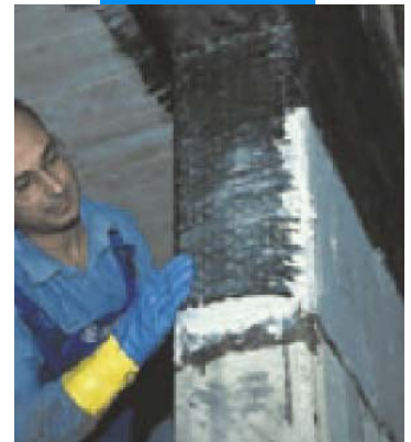
Обвязка колонн и балок
