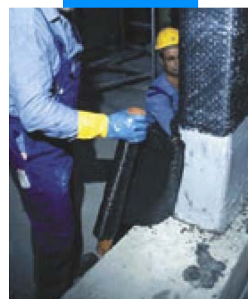
Укладка покрытия
