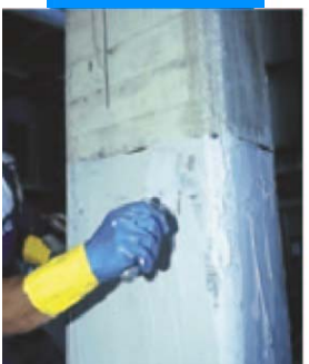
Нанесение шпаклевки Mapewrap 11 или Mapewrap 12
