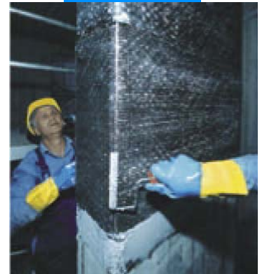
Укладка покрытия
