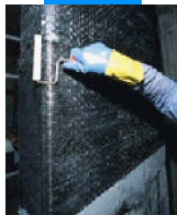
Нанесение второго слоя Mapewrap 31
