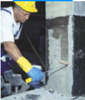
Нанесение Mapewrap Primer 1
