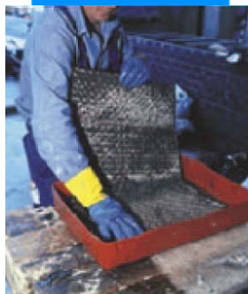
Ручная пропитка покрытия MapeWrap C
