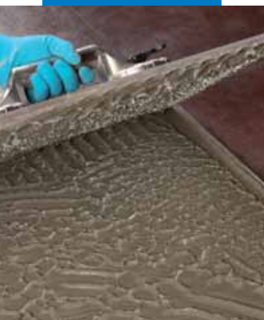
Вкладання крупноформатної плитки
