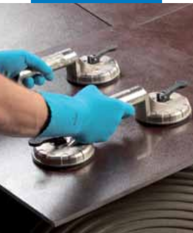
Вкладання крупноформатної плитки
