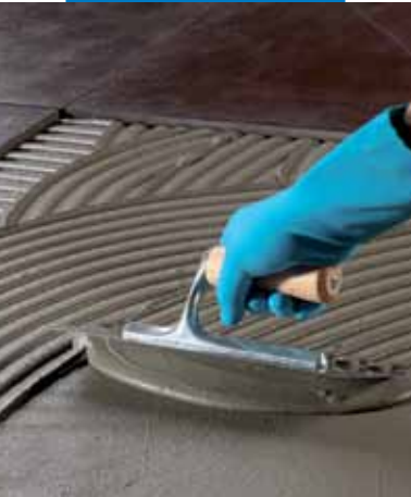
Нанесення Keraflex Easy на основу за допомогою зубчатого шпателя із закругленими зубцями у формі напівмісяця
